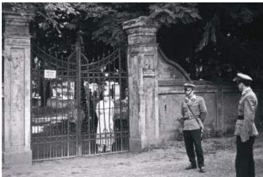
10. Brama główna szpitala ospowego w Szczodrem. Przed bramą całodobowo wartę trzywali milicjanci z Milicji Obywatelskiej. Posterunek MO utworzono po pojawieniu się plotki o rzekomych planach podpalenia szpitala. Za bramą widoczna postać Jana Woźniaka, tzw. portiera, który był jedynym łącznikiem odizolowanych ze światem. To on kwitował odbiór szczepionek, leków, żywności czy potrzebnych w danej chwili sprzętów. Był pierwszym, który witał lub odprowadzał gości: zarówno tych natrętnych, jak i oficjalnych.
